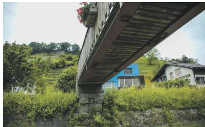
Brücke mit Blick auf den Thaler Rebberg.
